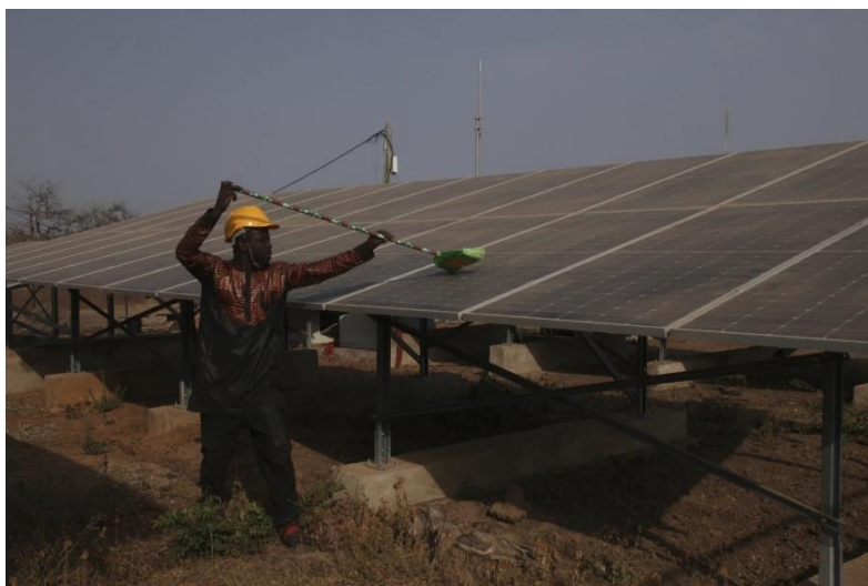
Figura 3-6. Mantenimiento de paneles en una mini-red solar rural en Karan, Mali. Un técnico realiza labores de limpieza en los módulos fotovoltaicos de la planta solar comunitaria que abastece a la aldea de Karan, Mali (AP Photo/Baba Ahmed, 6 febrero 2025). La imagen ilustra la importancia de las tareas de operación y mantenimiento para garantizar el rendimiento de las mini-redes rurales (B. Ahmed, 2025).
