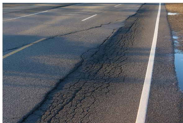
Figura 1-8: Rutting longitudinal
