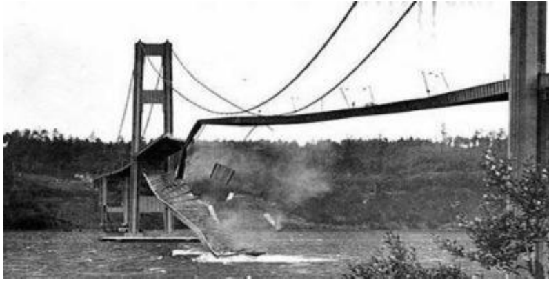
Fuente: Puente Tacoma Narrows, derrumbado debido al fenómeno de resonancia mecánica.
